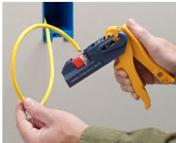
**Etapa 4:** certifique-se de que a tomada está segura e completamente inserida em um suporte de tomada com slots IDC voltados para as lâminas.
